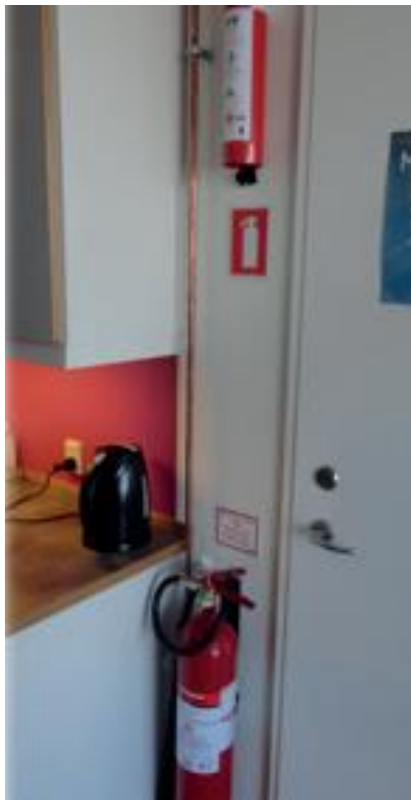
Figur 10: Brandtæppe & CO 2 -slukker på DBI
