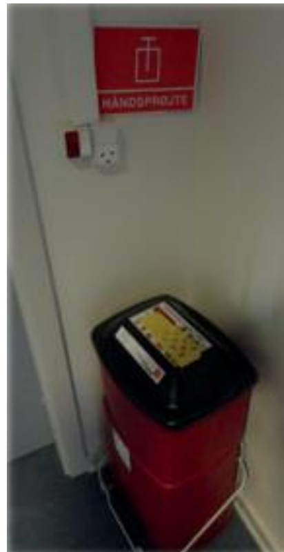
Figur 11: Håndsprøjte/-batteri på DBI
